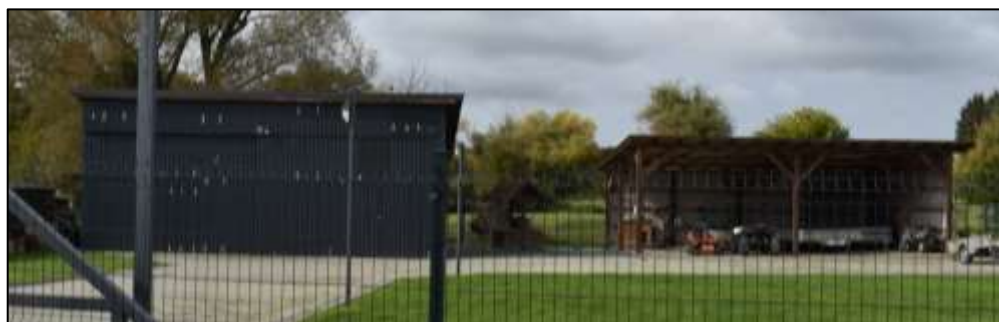
A 0134/4 hrsz-ú telken épült tároló épületek
