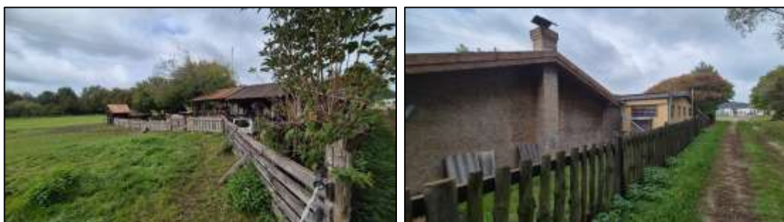
A 0134/6 hrsz-ú telek északi részén meglévő épületek, építmények
